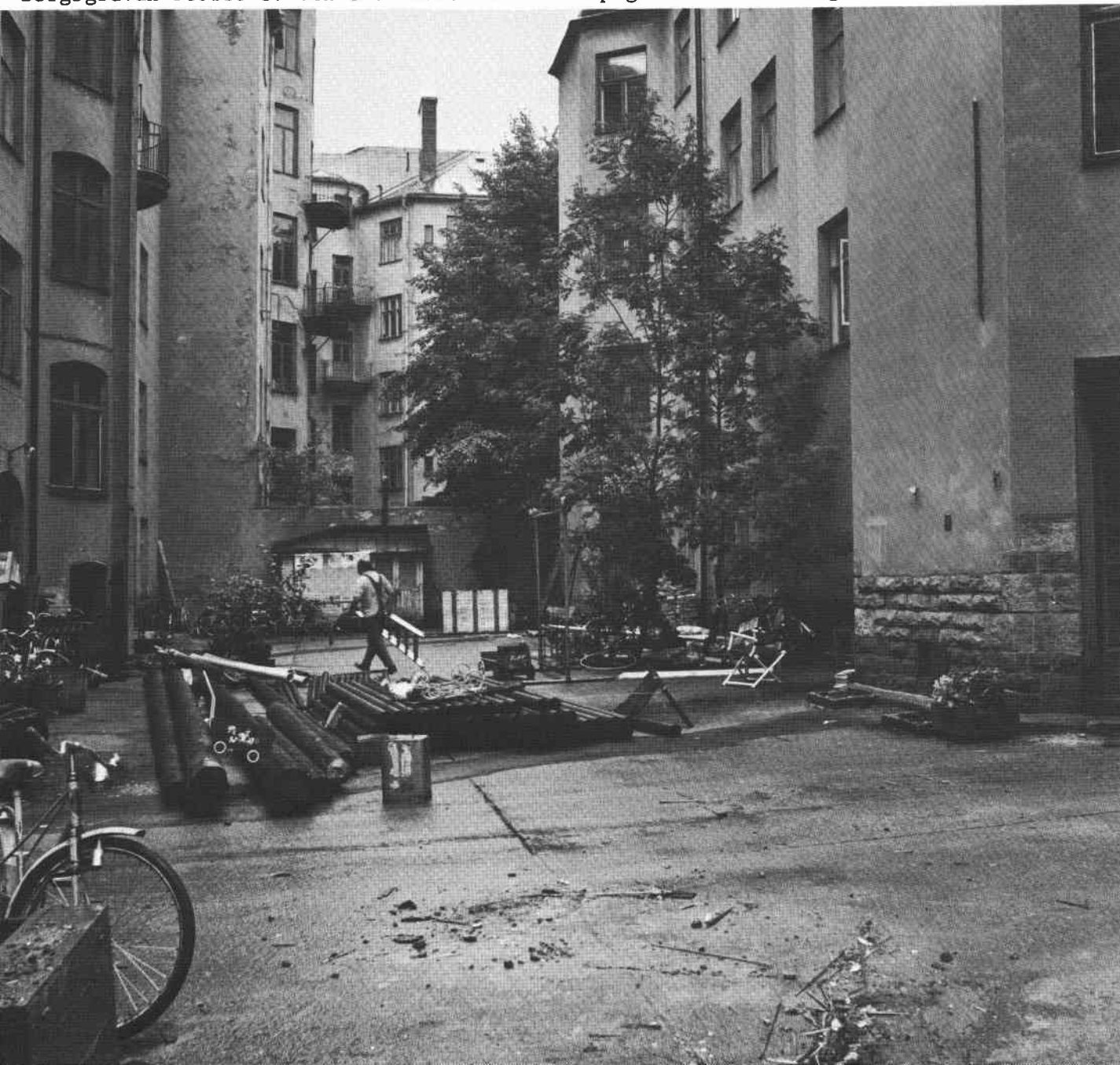
Bergsgruvan Större 37 och 38. Gårdsbild under pågående renovering.
