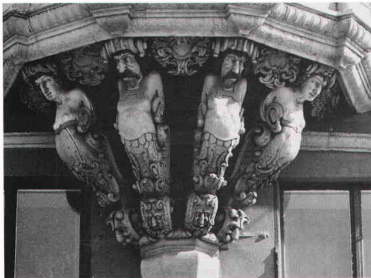
Detalj av burspråket mot Kornhamnstorg. Möjligen kan den äldre och kortare flygeln från 1620-talet ha haft detta burspråk. När flygeln vid 1600-talets mitt förlängdes fram till torget är det troligt att burspråket flyttades till sin nuvarande plats. De fyra stödjande hermerna, som är skurna i ek, står formmässigt mycket nära regalskeppet Vasas dekorativa figurer från 1620-talet. Foto Ingrid Wilken 1991. SSM.
