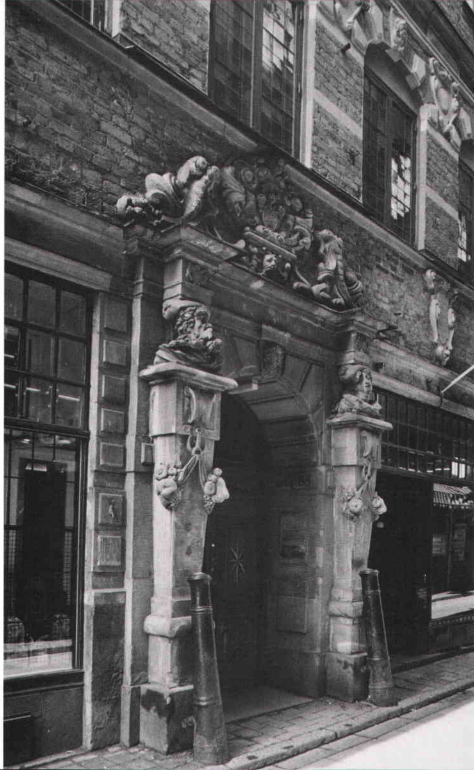
Västerlånggatan 68. Von der Lindeska husets ursprungliga portal flän- keras av stora butiksfön- ster vilka tillkommit under 1900-talet. Kring fönstret på övre våningen ser man delar av 1620-talets rika utsmyckning. Foto Ingrid Wilken 1991. SSM.
