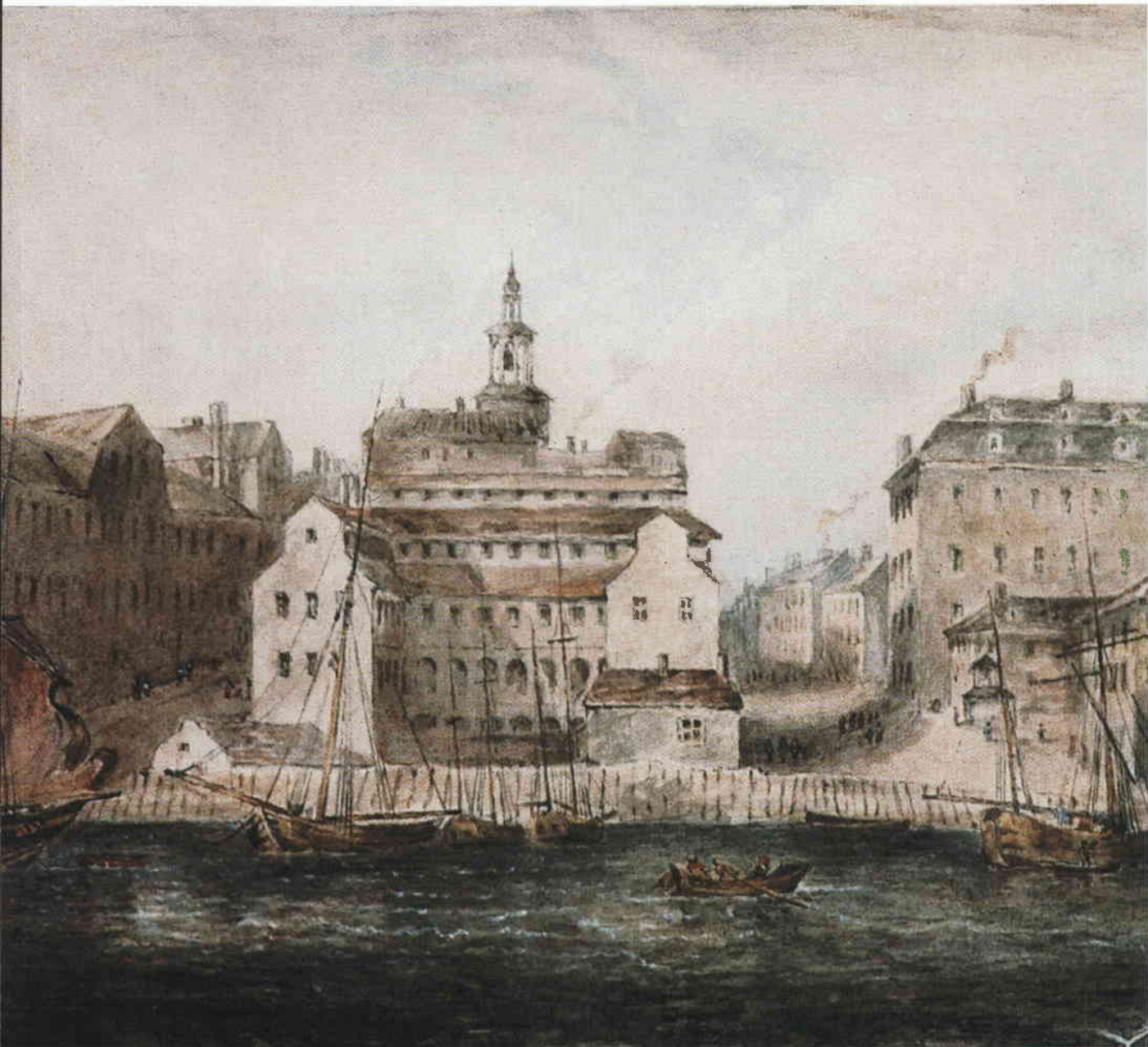
Södra stadshuset och Brunnbacken från sjösidan. Akvarell av Ince, 1833. Kopia. SSM.
