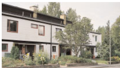
Tystnaden 1–15 vid Astrakängsgatan 190–218 i Hässelby Gård 1957–58. Det blev ofta eternitfasader på dessa hus då det var ett hållbart, billigt och modernt material. Foto: Ingrid Johansson, 2001.
