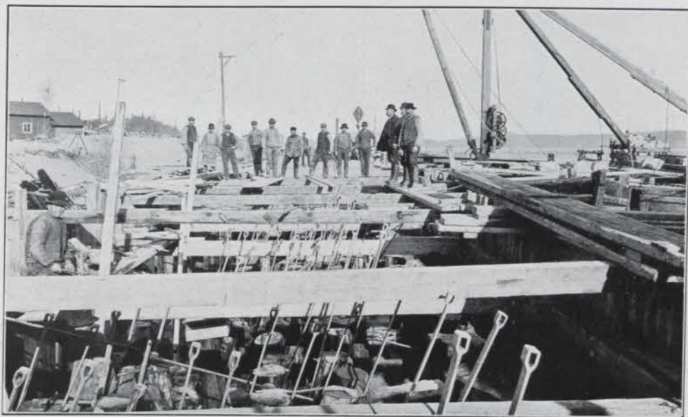
NYA HAMNBYGGNADEN. LÄNSPUMPAD INDÄMNING FÖR KAJBYGGNADEN, VISANDE PÅLRUST MED JÄRNFÖRANKRINGAR, INNAN BETONGJUTNINGEN PÅBÖRJADES.
