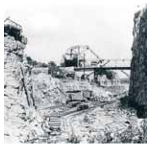
Spräng- och schaktningarbete genom Danviksklippan för Danvikskanalen 1923.
