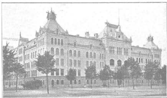
Ägare: Nömanda församling. Arkitekt: E. Berglund. Byggnästare: L. Östlika.
