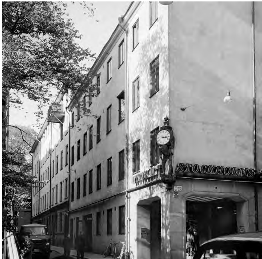
Hörnet Vattugatan och Klara Södra kyrkogata med ingången till Aftonbladets och Stockholms-Tidningens redaktioner. Den stora klockan sparades och sitter i dag på den nya kontorsbyggnaden. Foto: Åsa Wall.
